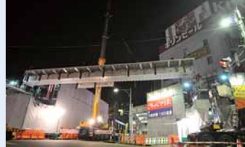
▲橋桁の取り付け(6月10日未明)
