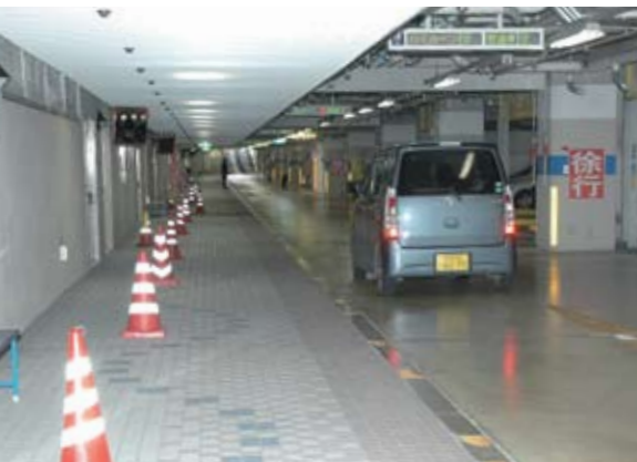
▲大手通り地下駐車場
