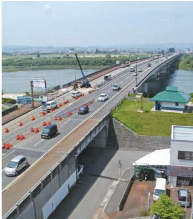
▲工事中の様子。巨大な橋りょうを橋脚の間に渡しています（平成19年10月13日撮影）
