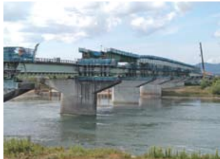
▲工事中の様子。巨大な橋りょうを橋脚の間に渡しています（平成19年10月13日撮影）
