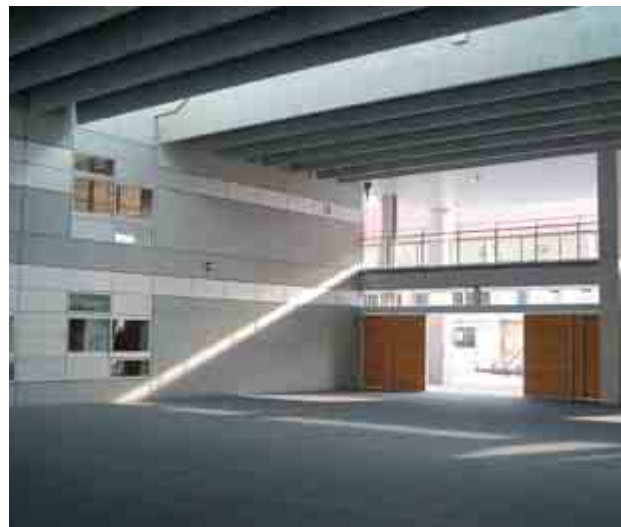
▲東中学校新校舎に整備した体育館と校舎の間の屋根付き広場。雨や雪でも支援物資の搬入、ケガ人の搬送、仮設トイレの設置などができます
