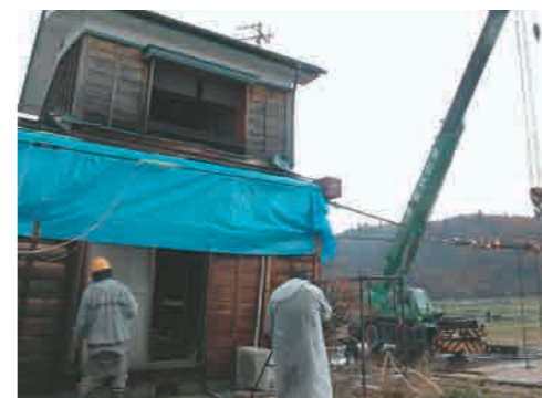
▲クレーン車を使い住宅の耐震補強の効果を調査(柿町)
