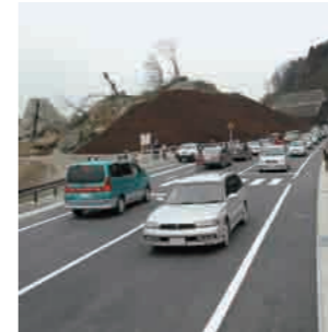
▲3月24日 3年前の中越大震災による大規模な土砂崩れで崩落した県道が開通
