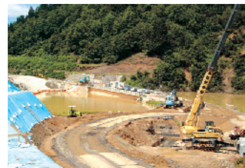
▲復旧工事中の国道291号 (東竹沢地区・平成17年7月)
