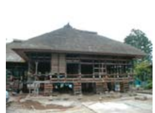
▲中越大震災の被害から復旧 中の旧長谷川家住宅
