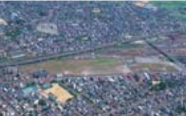
▲長岡操車場地区全景
