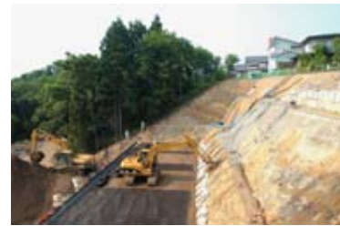
▲雪どけを待って市内各地で災害復旧工事が本格的に始まりました（写真は高岡団地の道路復旧工事・6月21日撮影）。
