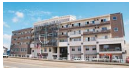
▲大手大橋側から見た「高齢者センターしなの」（建物の2階部分。入口は北側）
