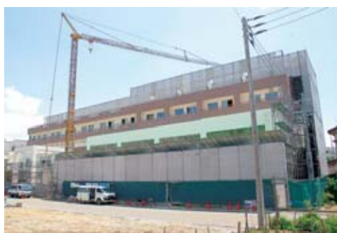
▲完成間近の「高齢者センターしなの」(建物の2階部分)
