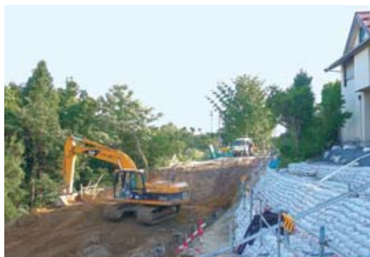
▲道路の復旧工事が進む高町団地
