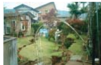
▲亀裂に伴う沈下
