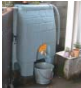
◀家屋の雨どいからの雨水を集め、一時的に貯留する150リットルのタンク。タンクの形や容量は数種類あります
