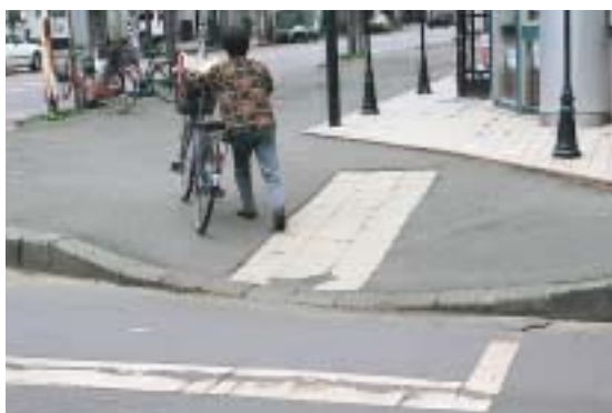
▲歩道にかなりの傾斜があって、車いすなどで渡るのは大変です。(城内町3丁目) ▼歩道優先の考え方から、車道を盛り上げて歩道との段差をなくした最近の整備事例。(表町4丁目)
