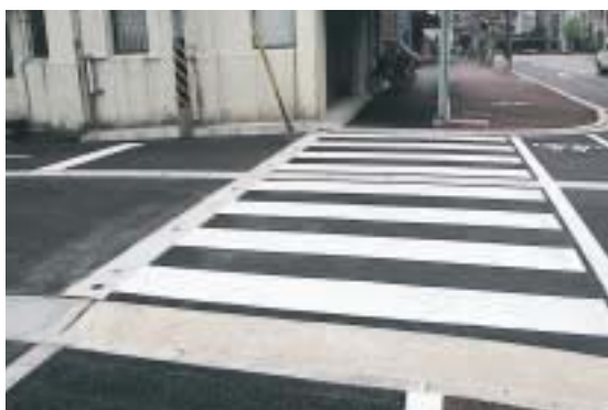
▲歩道にかなりの傾斜があって、車いすなどで渡るのは大変です。(城内町3丁目) ▼歩道優先の考え方から、車道を盛り上げて歩道との段差をなくした最近の整備事例。(表町4丁目)
