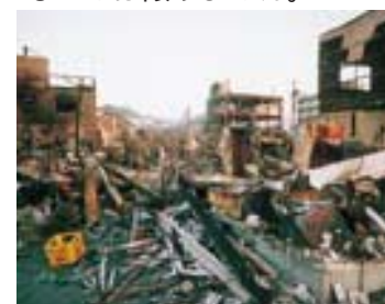
阪神・淡路大震災で焼失した建物
