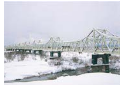
長生橋(平成13年1月19日撮影) 今の長生橋は長さ850メートル、橋脚の基礎深さ12メートルの13連式の下路式ゲルバー鋼構橋です。その姿は当時の橋りょう建築の粋をあつめた傑作といわれています。
