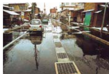
車道にはシャーベット状の雪が残ることもありますが、走行に大きな支障はありません（道路の中央が排水溝）
