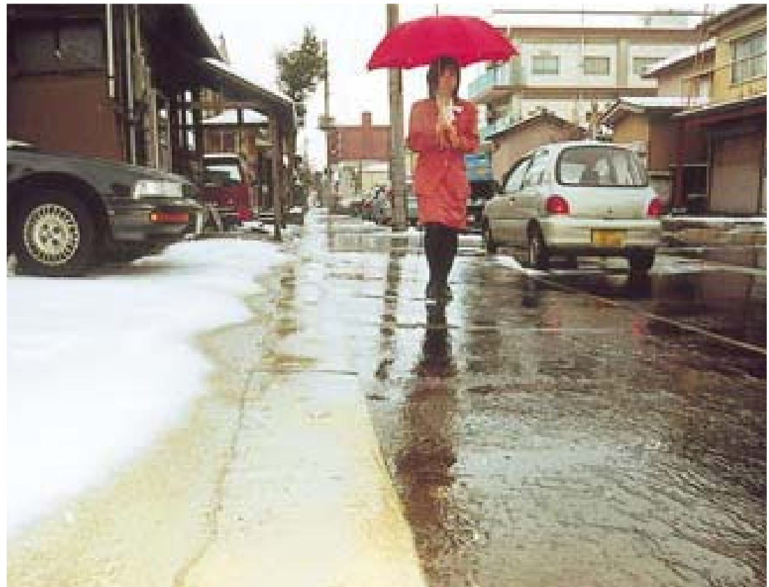
歩道上に消雪パイプを設置した新しい構造の道路。歩道の雪がきれいに消えています（12月12日・千手2丁目）
