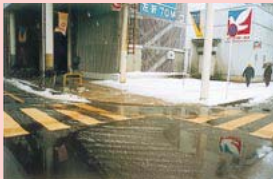
設置後（横断歩道上にかかる曲線部分が設置した消雪パイプ）
