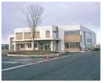
完成間近な余熱利用施設温水プールや浴場などがあります。
