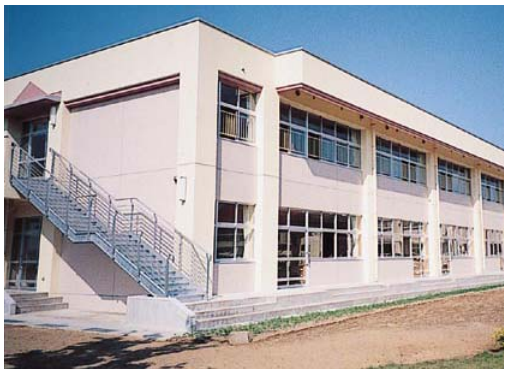
完成した高等部の校舎
