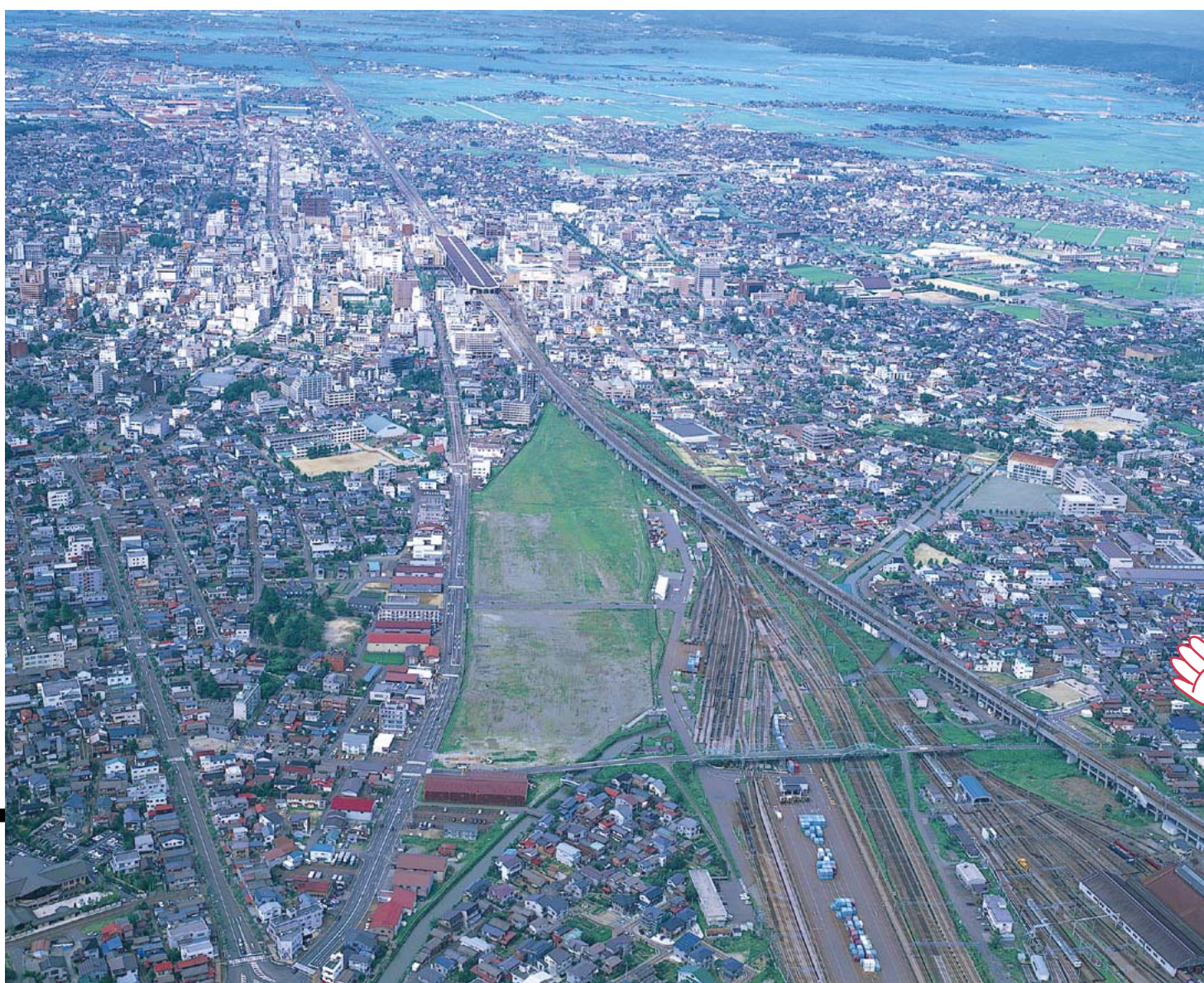
長岡操車場地区 平成11年7月25日撮影
