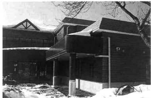
▲完成間近な宮本地区福祉センター
