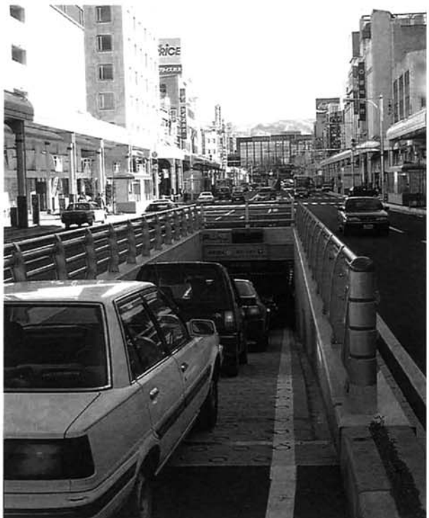
▲昨年12月13日に完成した地下駐車場。これで大手通りメインストリートの整備事業は終了した
