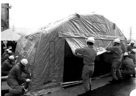
▲組み立てられたエアータント 大きさは間口6m×奥行6m×高さ3mで、重量が約100kg。1分15秒で設置できます。
