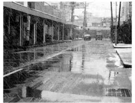
消雪パイプ (坂之上町1)
