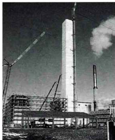
▲建て替え工事の進む寿ごみ焼却施設
