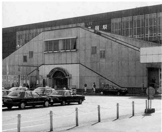
▲エレベーターが完成した長岡駅東口。地下自転車駐車場も現在建設が進められています
