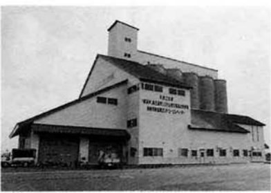
▲長岡市農協東カントリーエレベーター
