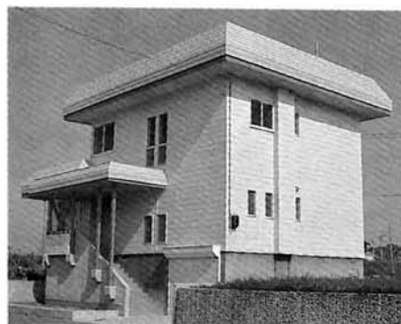
▲長岡ニュータウン内の木造耐雪住宅
