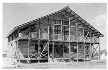
山小屋風の農業実習研修棟
