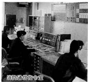
消防通信指令室
