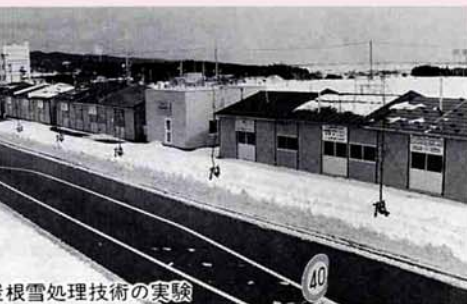
屋根雪処理技術の実験
