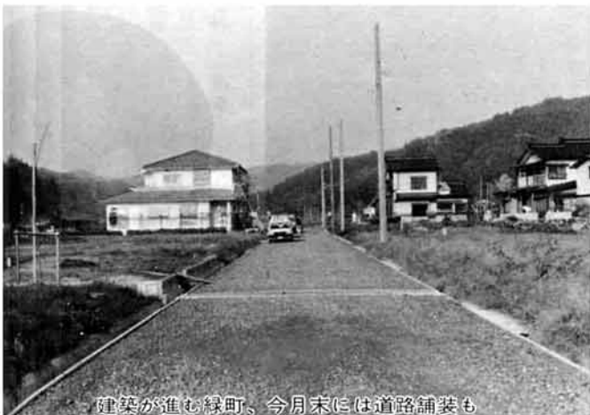
建築が進む緑町、今月末には道路舗装も
