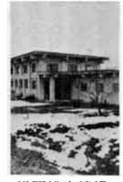
鐵研排水機場
