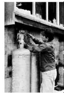
ガス工場の作業員がガス配管の工事を行っている様子。
