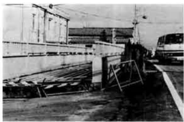
工事中の歩道橋
