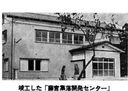
竣工した「藤宮集落開発センター」
