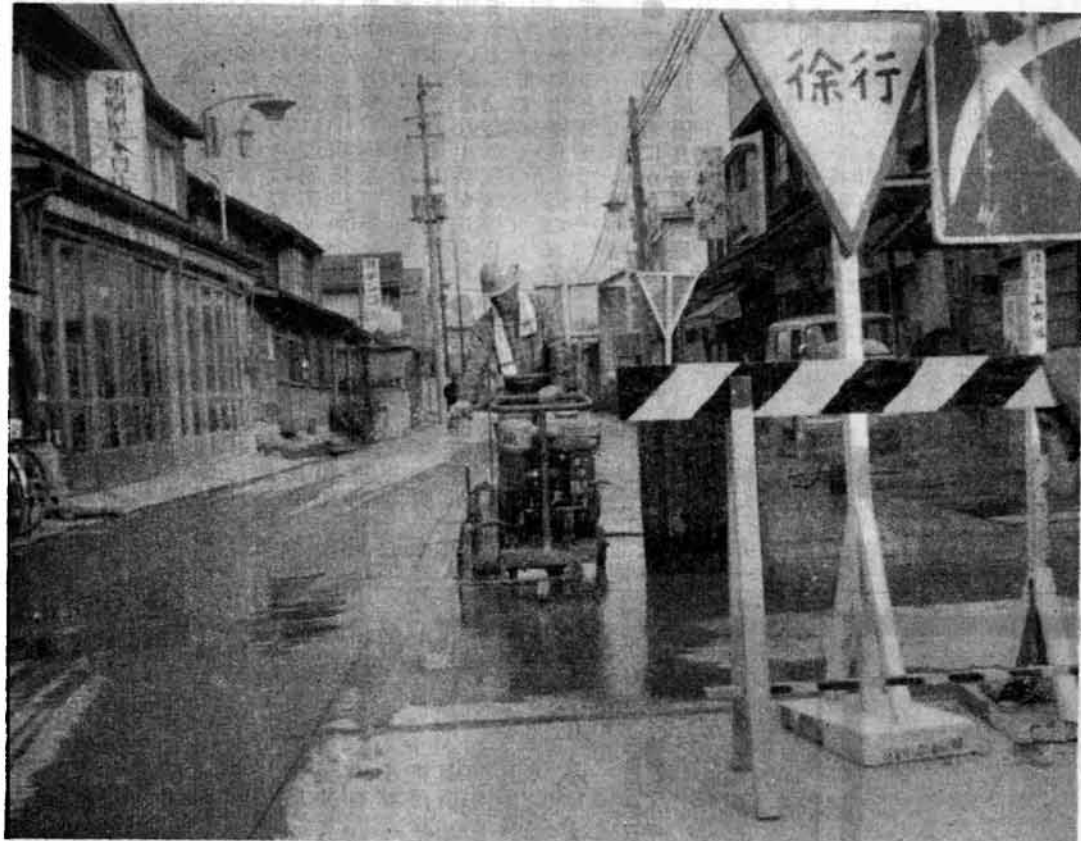
消雪パイプラインの切断作業をするコンクリートカッター
