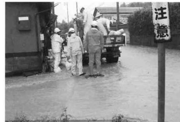
▲消防団による土のう積み作業
