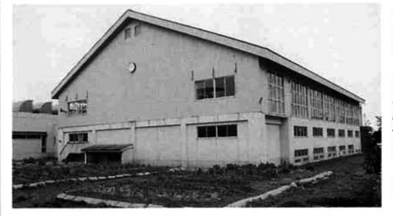
▲ 脇野町小学校体育館
