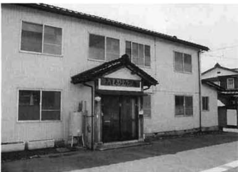
▲ 増築が予定されているあゆみの舎福祉作業所
