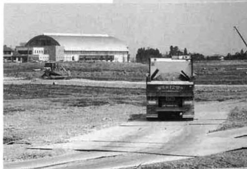
▲ ひんぱんにトラックが運行する上岩井地内、土地区画整理事業宅地造成工事
