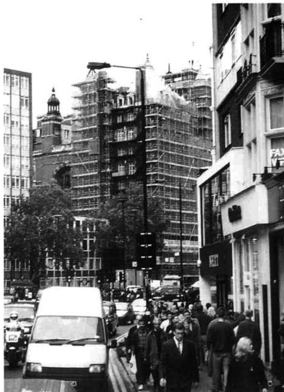
外壁等の補修工事が随所で見られました（ロンドン市内）
