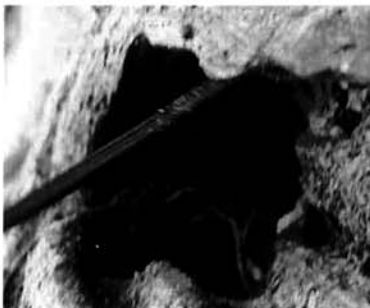
↓ 殺菌剤を塗布した後、着色したモルタルで擬木処理
