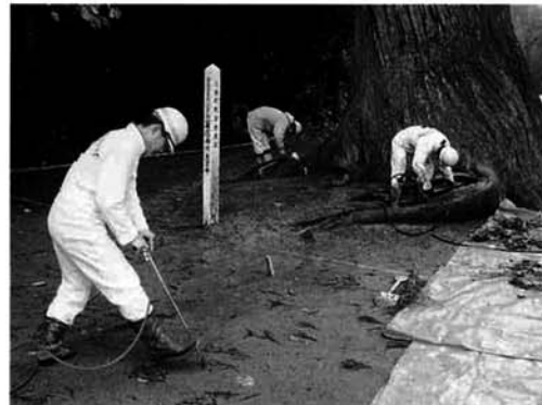
樹冠下の土の中に圧縮空気を入れ、固くなった土壌を柔らかく膨らませます
