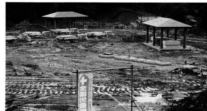
工事が進む(仮称)大杉公園
