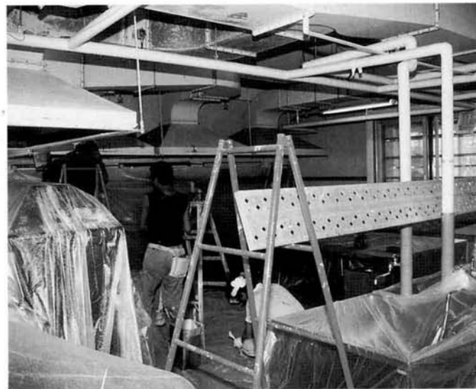
改装中の給食室
