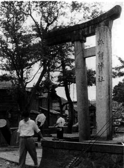
新潟地震（昭和39年6月・マグニチュード7.5）で割れ、片足で立つ吉崎諏訪神社の鳥居 （写真提供：松村清吉さん（吉崎））
