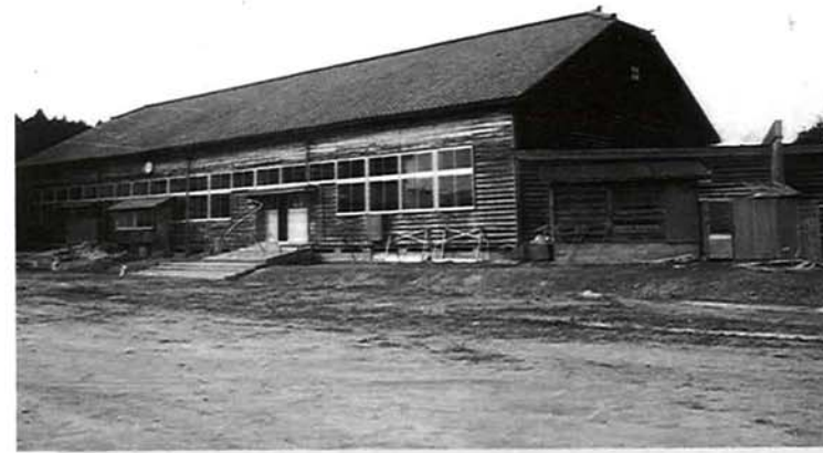
取り壊される日吉小学校 体育館
