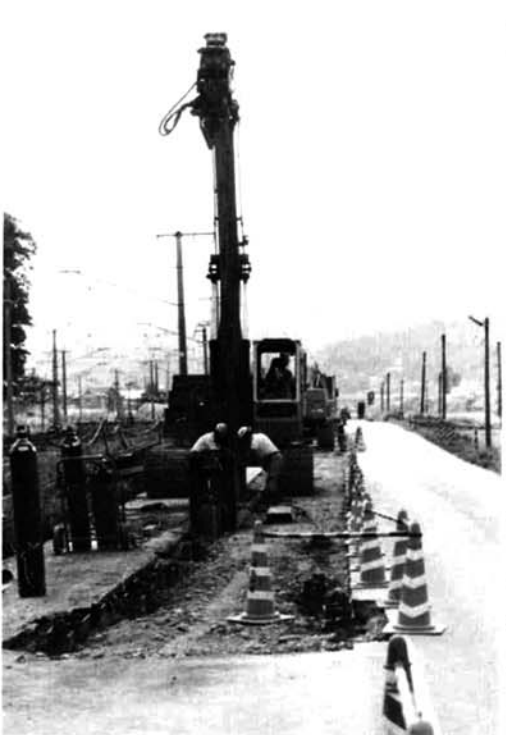
▶急ピッチで進む下水道工事(中島)
