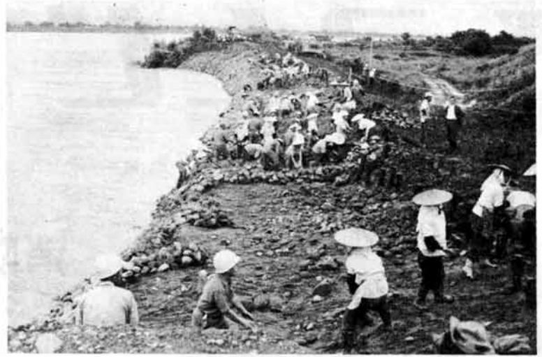
徹夜での復旧作業で決壊を食い留める
