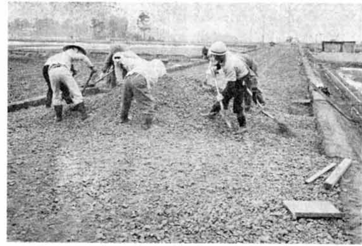
雪が少ない冬で工事がやりやすい、須川橋～中島部落
