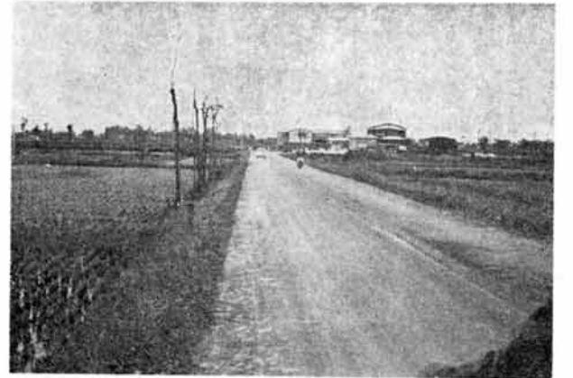
路盤工が完成した神谷～岩野間
