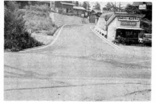
（舗装完了した西谷の町道）
