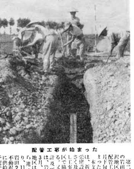
第二次ガス配管工事の現場
