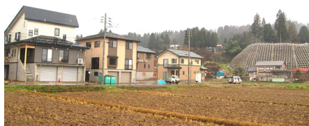
↑<西谷地区> 崩壊した崖の復旧も終わり、移転団地も完成。復興はほぼ完了しました。
