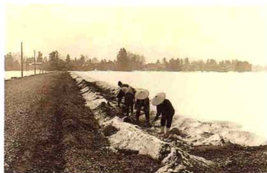
昭和51年3月、町道が未舗装のため、除雪で田に入った砕石を雪が消える前に取り除く作業が行われた
